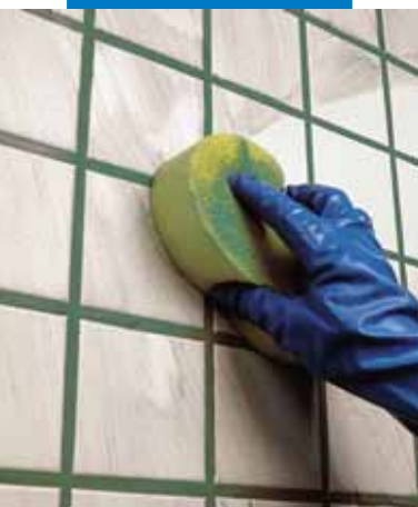
Pulizia e finitura delle fughe a parete con spugna
