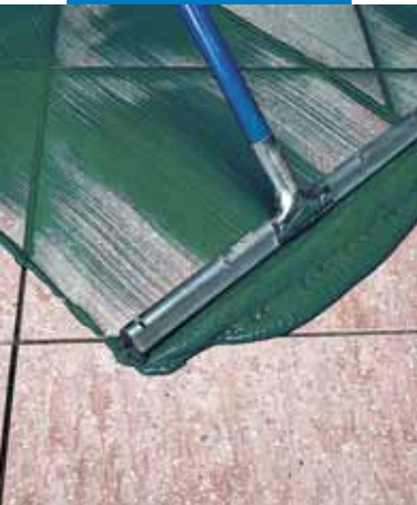
Stesura di Ultracolor Plus a pavimento con racla
