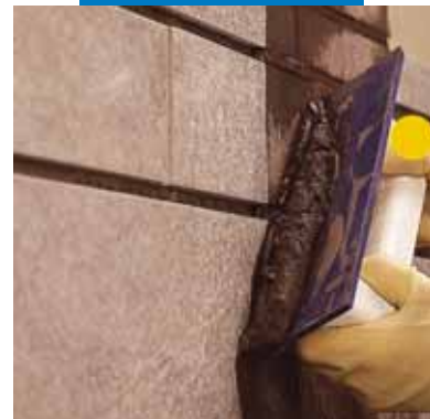
Stesura di Ultracolor Plus a parete con spatola di gomma
